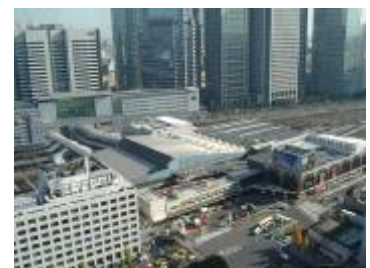
高輪口(西口)からの品川駅全景
